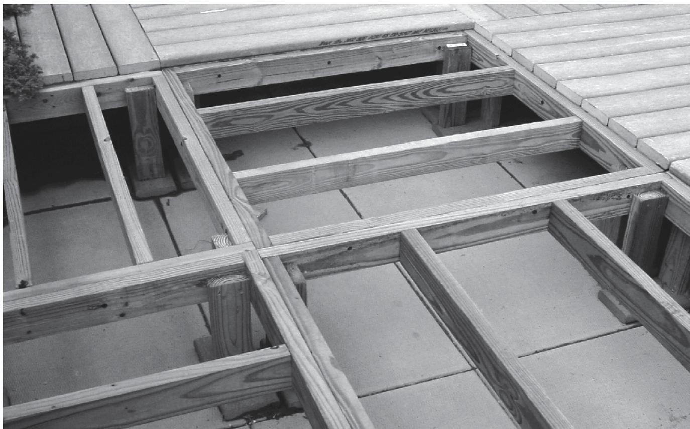
Un réseau de longrines est un tampon entre une surface pleine et une terrasse Trex®. Le drainage, l'accès et la circulation d'air sont critiques. L'eau doit pouvoir s'écouler au travers et loin de la terrasse. Pour les réparations et l'élimination des débris, un accès au réseau de solives est nécessaire. Une bonne circulation d'air permettra de maintenir la terrasse sèche et en bon état.
